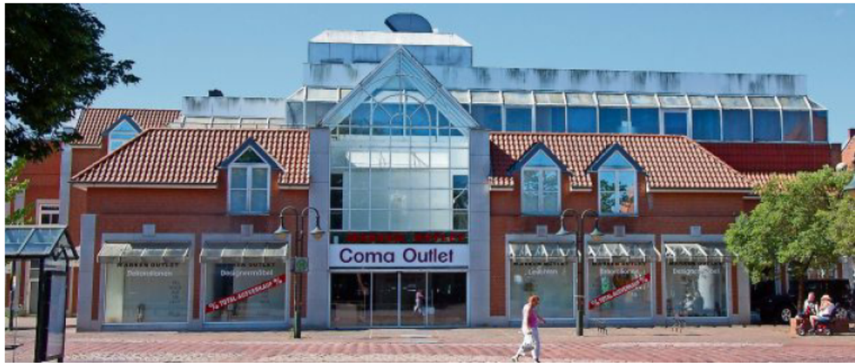
Soll nach den Plänen der Ratsmehrheit und des Investors bald einem Neubau weichen: das ehemalige Kammann-Gebäude auf dem Rathausplatz.
